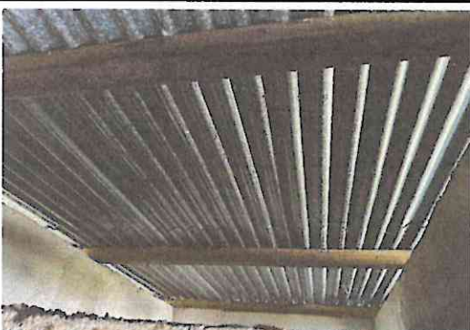
Foto 3: Sustrucción de estructura de madera por deterioro en baños
