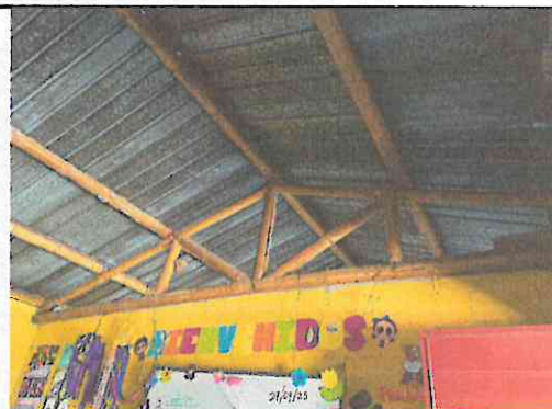
Foto 4: Sustrucción de estructura de bambú deteriorada Salón 1
