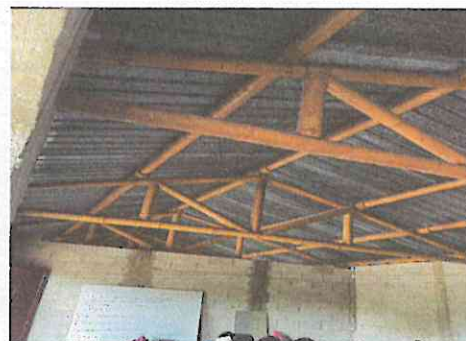
Foto 6: Sustrucción de estructura de bambú por deterioro en salón 2
